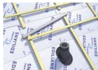
**8** - L'objectif est de dévier l'eau qui est sur la trajectoire de points singuliers à risque de pénétration, pour cela on crée un « déflecteur » en enroulant un morceau de lés d'écran autour d'un liteau placé à 45°. Une fois le déflecteur mis en place l'eau est déviée sur la travée adjacente. Le bout d'écran enroulé autour du liteau doit être placé en partie haute sous la lés d'écran supérieure.
