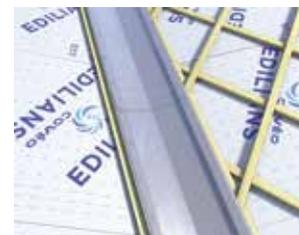
**5** - L'écran HPV peut être au contact de l'isolant. En faitage celui-ci est fermé par la mise en œuvre d'une bande d'écran de débord 20 cm et centrée. La non ventilation en sous face de l'écran HPV Aéro assure une performance thermique optimisée de l'isolant.
