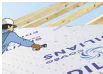
**1** - Installation entre chevrons ou sur support continu : dérouler en pose tendue, parallèlement à l'égout, en démarrant par la partie basse du toit. La pose s'effectue en lés successifs de l'égout vers le faitage. Le recouvrement est de 10 cm pour les pentes supérieures à 30%, 20 cm sinon.
